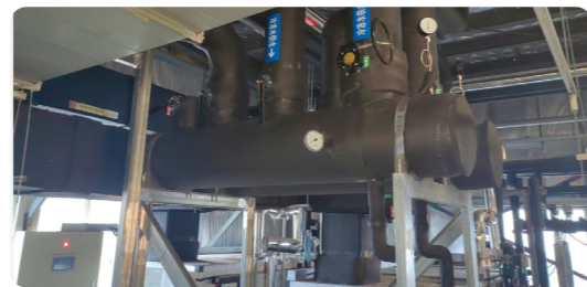
车间冷水系统改造
