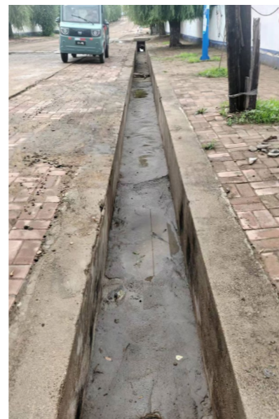
排水系统改善工程
