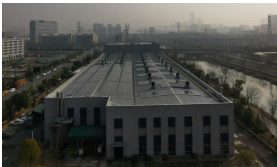
永乐一期光伏项目
