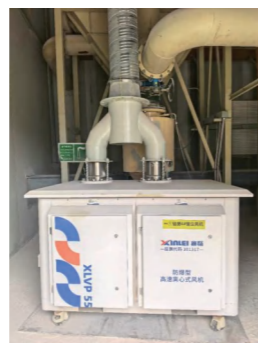
VOC净化处理塔喷淋系统、粉尘房防爆风机改造
