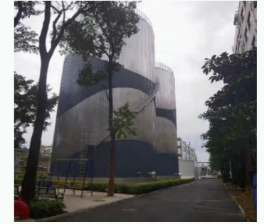
高效机房节能减排项目
