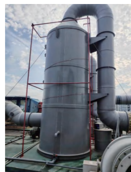
VOC净化处理塔喷淋系统、粉尘房防爆风机改造
