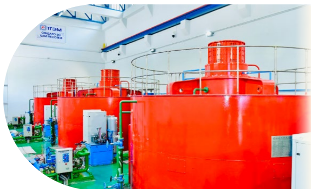
塔吉克斯坦塞布佐水電站三臺機組實現“三日三連投”，全部併網發電。
