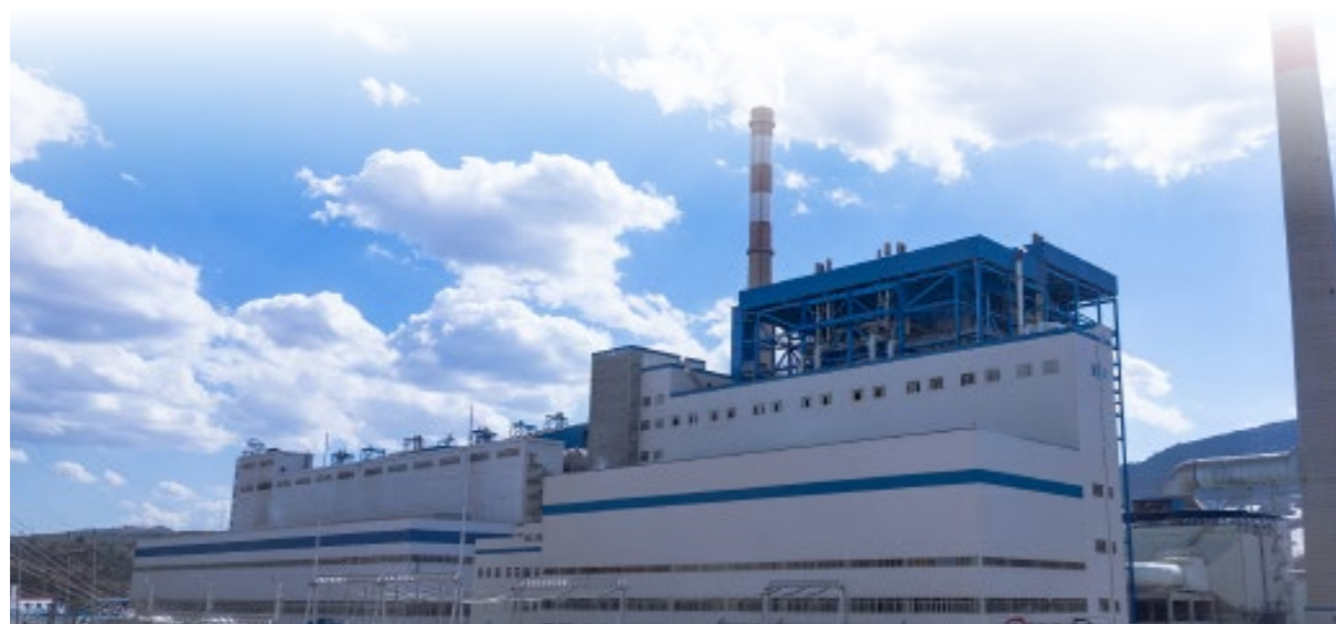
世界首臺700兆瓦超超臨界循環流化床鍋爐正式投運，成為滇南區域最大的穩定電源支撐點。
