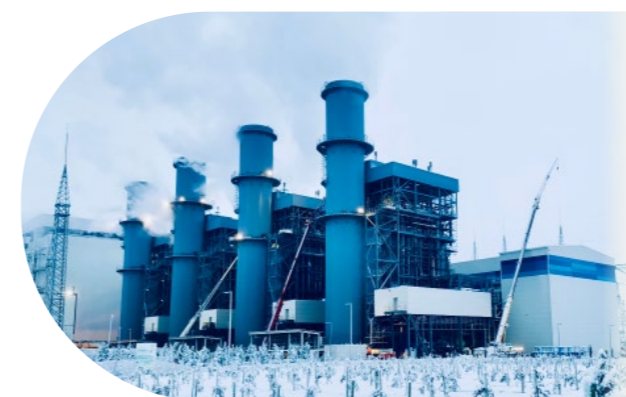
阿塞拜疆明蓋恰烏爾聯合循環項目正式投運，東方電氣為該項目提供四臺F級餘熱鍋爐及其附屬設備。
