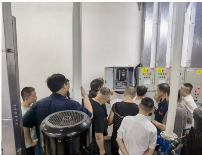
西中心生活水泵房節能改造項目現場
