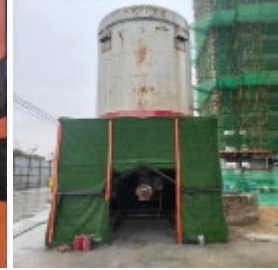
施工設備防塵降噪防護
