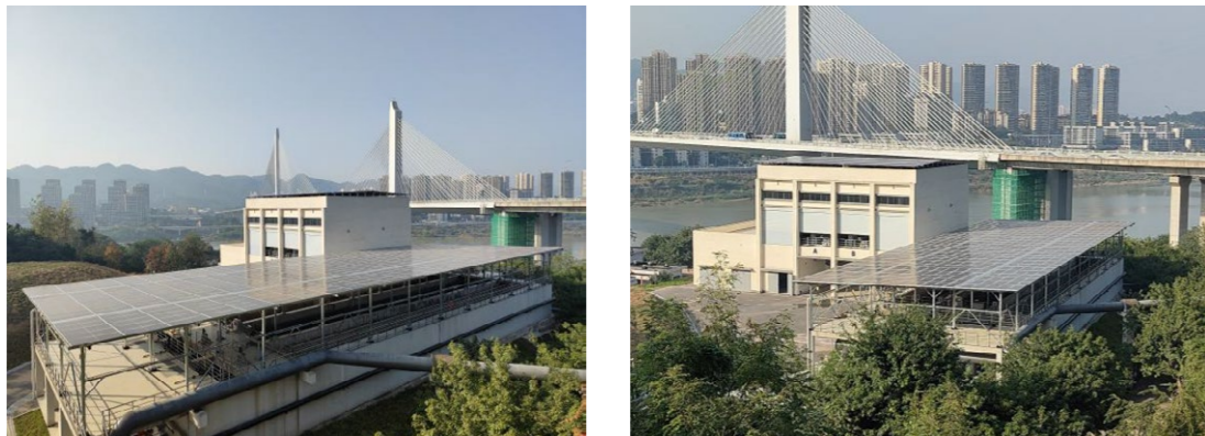
◆ 重庆梁沱水厂分布式光伏项目 ◆
