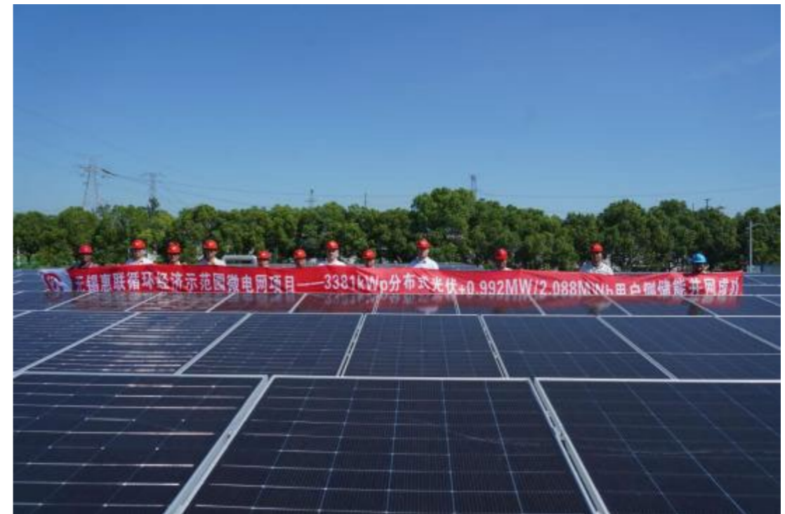
◆ 园区微电网项目 ◆
