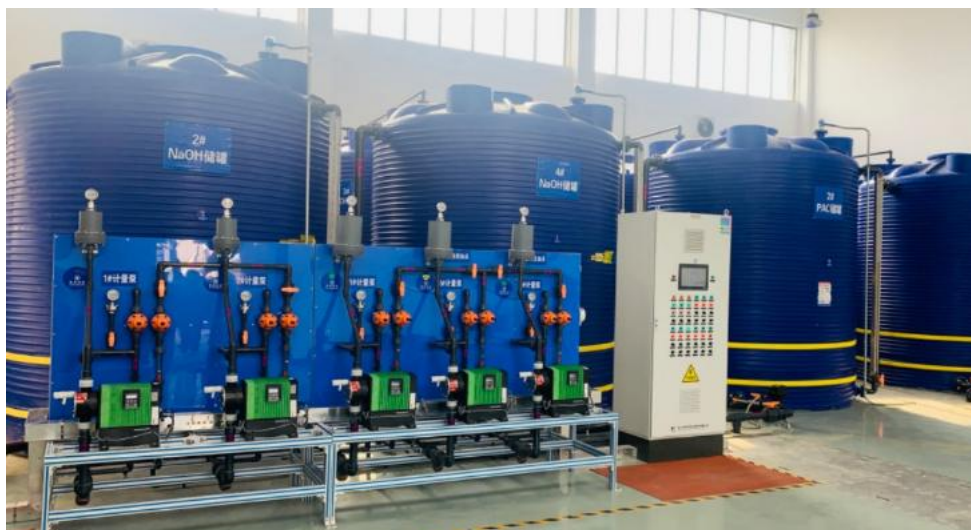
杭州临平自来水厂（2021）
