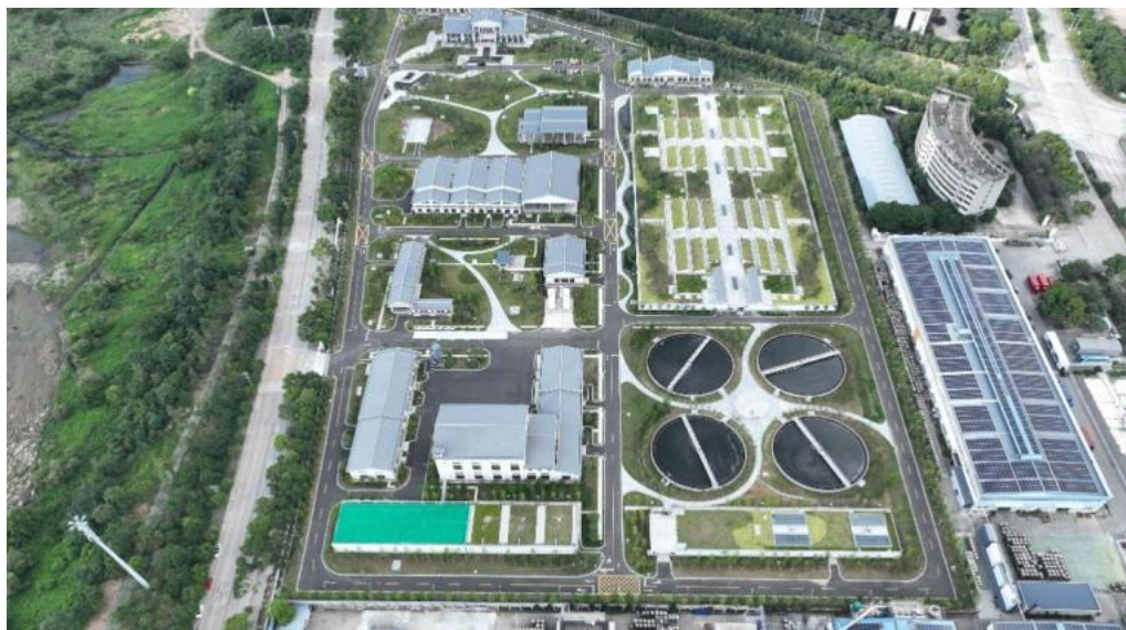
丽水市水阁污水处理厂污泥深度脱水示范工程（2023）
