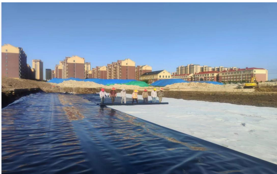
原瑞达焦化厂土地污染修复项目（2024）
