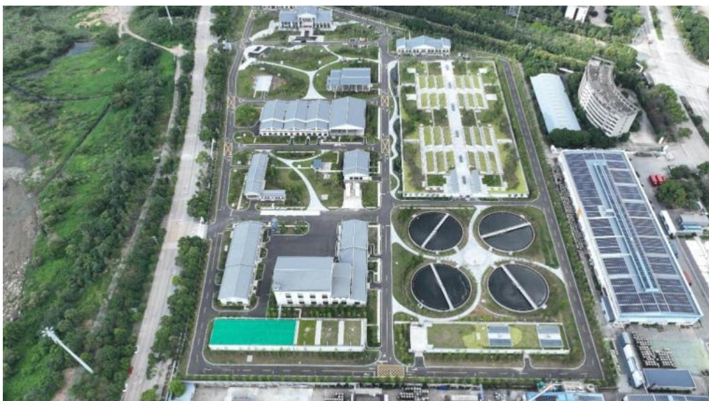
丽水市水阁污水处理厂污泥深度脱水示范工程（2023）
