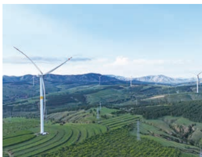
2024年12月，辽宁朝阳烧锅营子300兆瓦风电项目全容量并网
