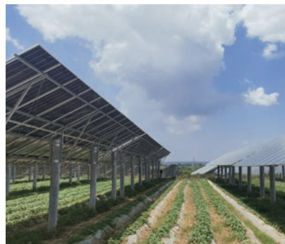
2024年12月、2025年5月，山西临汾浮山一期100兆瓦、二期100兆瓦光伏复合发电项目相继全容量并网
