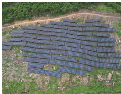
2025年12月，重庆云阳高阳65.6兆瓦光 伏项目倒送电一次成功
