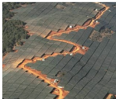
2025年5月，四川西昌佑君230兆瓦光伏发电项目全容量并网
