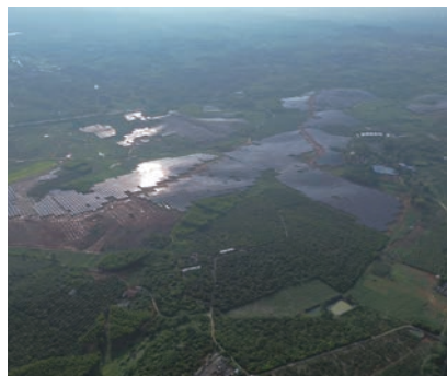
2024年12月，广西南宁武鸣300兆瓦农光储能一体化光伏发电项目全容量并网
