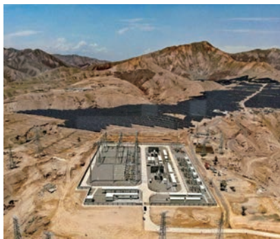
2023年12月，甘肃永登百万千瓦级光伏发电基地一期600兆瓦项目全容量并网
