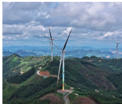
2024年12月，广西百色田林八渡200兆瓦风电储能一体化项目实现全容量并网
