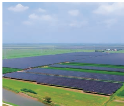
2025年5月，河北沧州光火储氢一体化多能互补示范项目全容量并网发电
