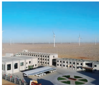
2024年10月，甘肃瓜州基地501兆瓦风电项目全部竣工投用
