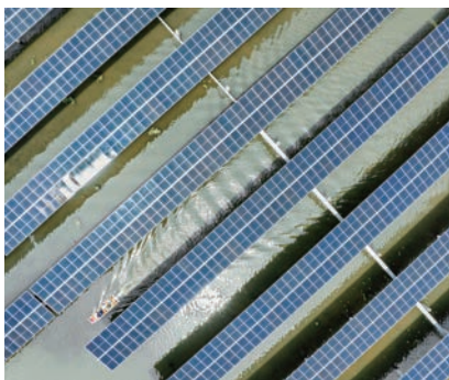
2023年12月，湖北省最大的“渔光互补”发电项目——赤壁日曜350兆瓦渔光互补光伏发电项目全容量并网
