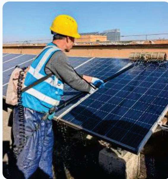
使用回收水源清洗光伏組件
