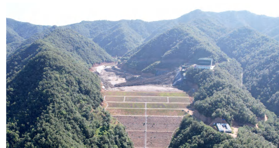
嵩县金牛公司尾矿库治理成效显著
