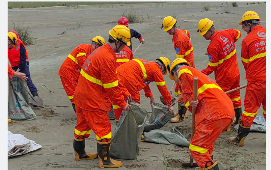
江西金山公司开展阳山尾矿库洪水漫顶突发环境事件应急演练，图为现场装沙筑坝
