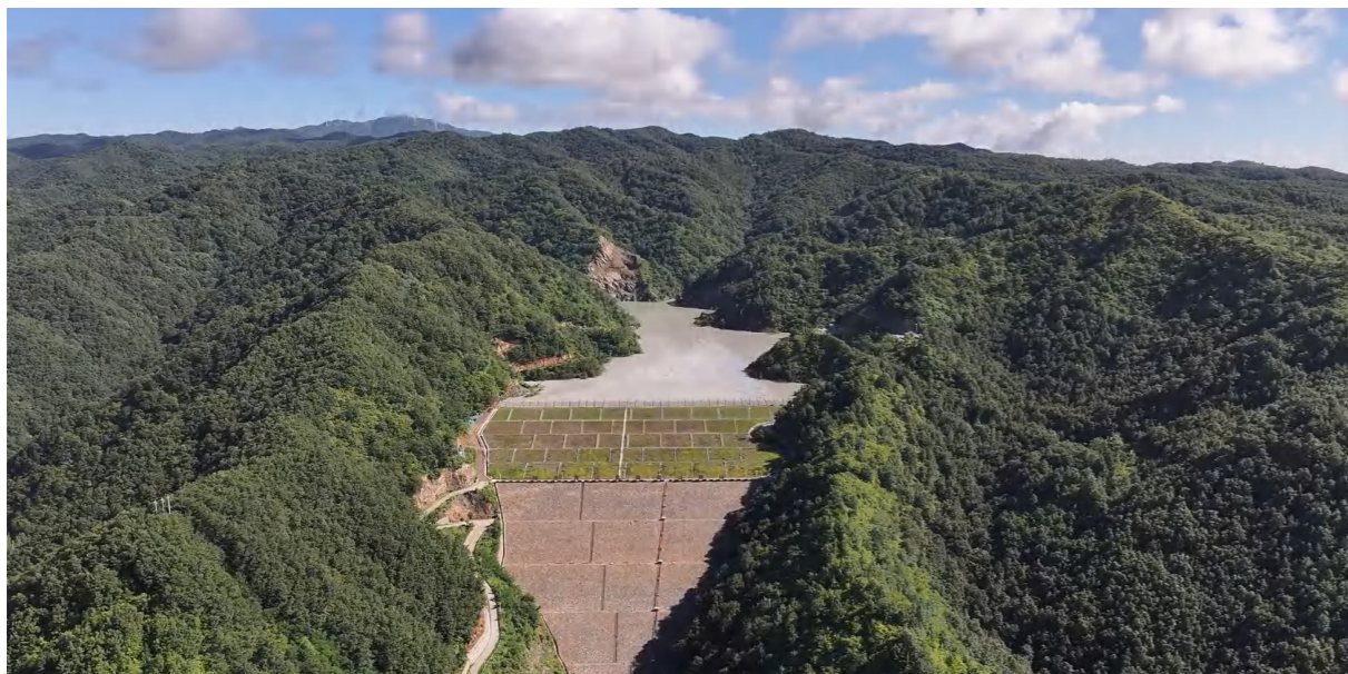
河南金源公司石门沟尾矿库
