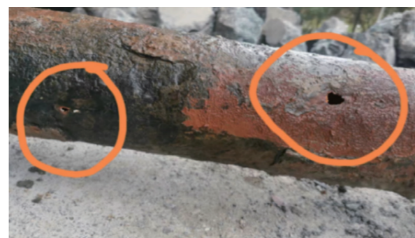
原管道镀锌管
