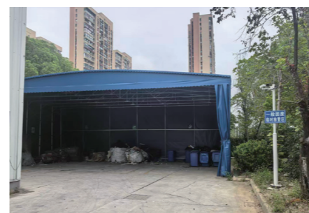
一般固废临时放置区
