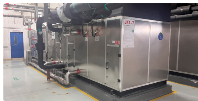
空调系统能量回收改造
