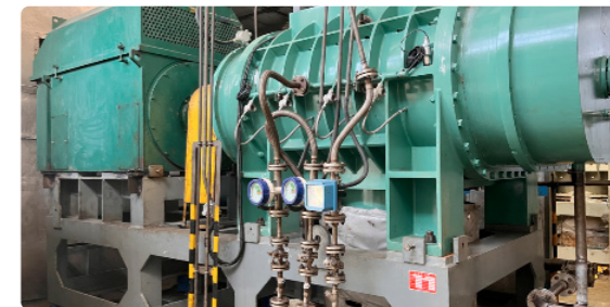
压缩机高压变频器改造
