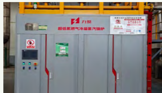
节能高效环保锅炉改造
