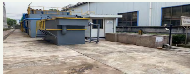
高低浓度污水处理设施改造
