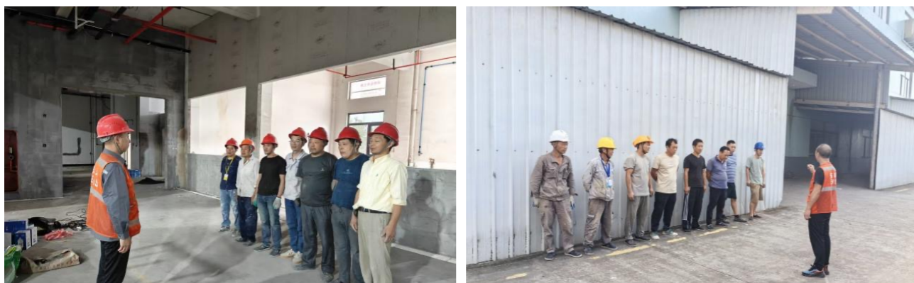
外来施工安全培训
