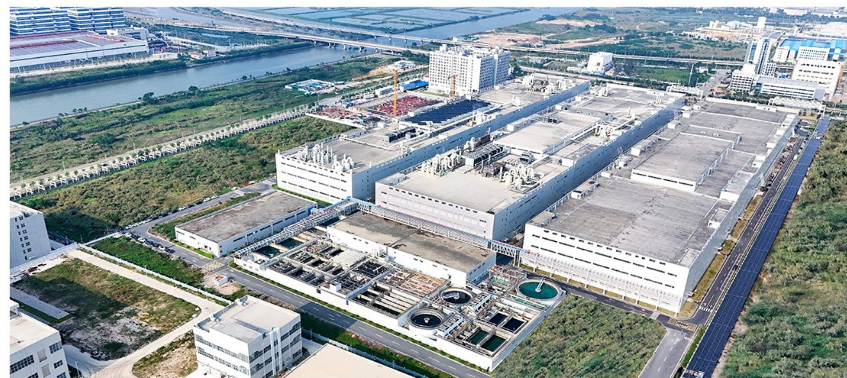
珠海厂废水站
