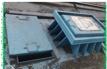
高要港 - 雨水與污水分流系統
