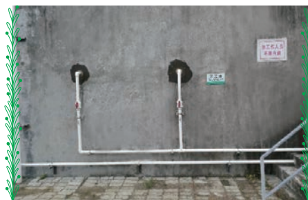
西域港 - 雨水與污水分流系統
