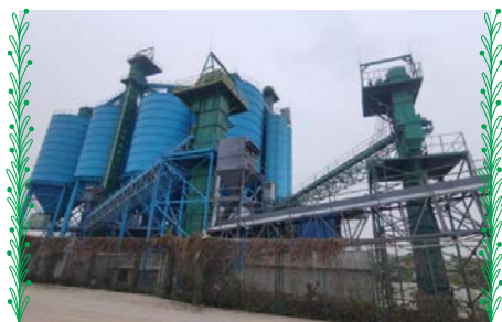
袋式除塵設備
