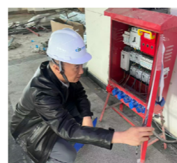
装修工程日常巡检
