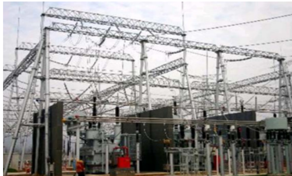
风电接网：送变电工程设计齐齐哈尔龙江二期 200MW 风电接网工程
