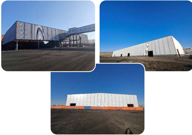
中旗區域三座新建封閉式煤棚
