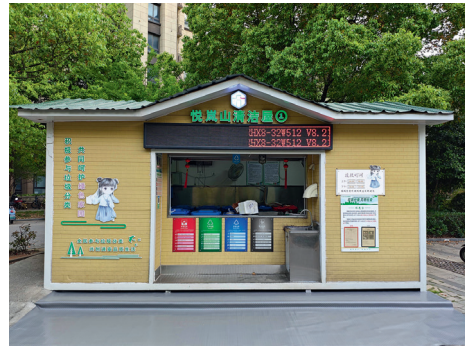
清運生活垃圾分類小屋 Domestic Waste Sorting & Collection Hut
