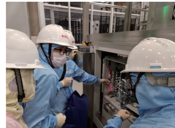
设备设施安全防护装置检查
