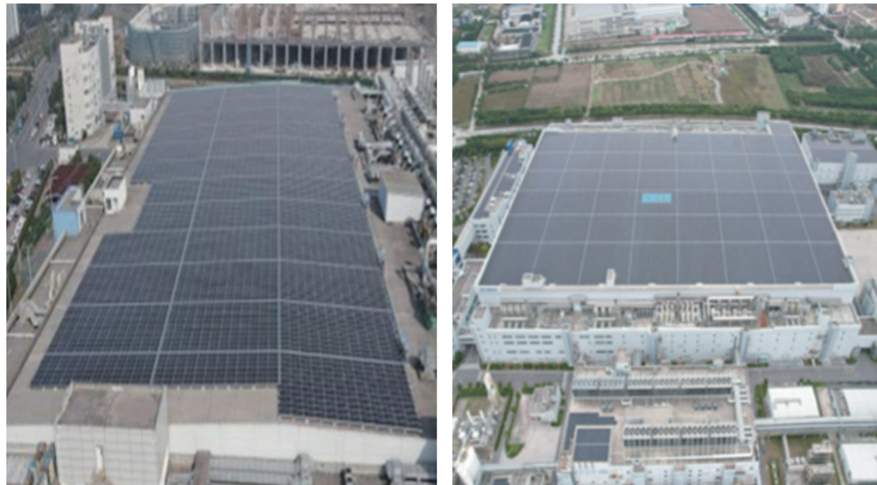
光伏项目建设
