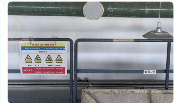
废气收集管整改后
