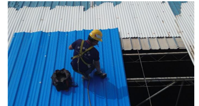
无人机监控委外施工瓦面维修安全
