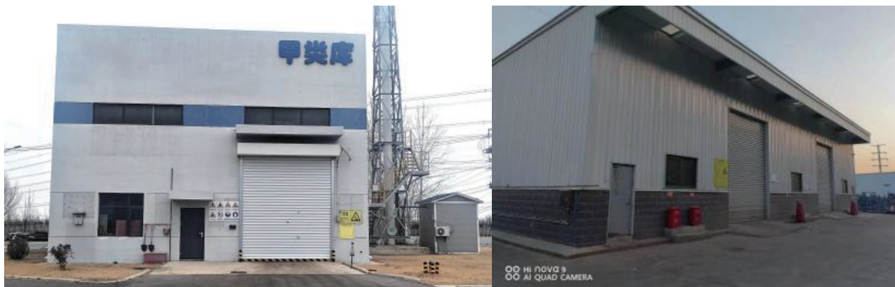
徐工机械危废品仓库
