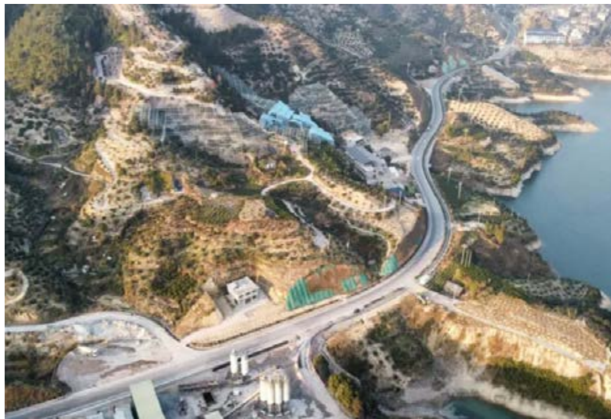
泰顺县司前至筱村公路全线通车
