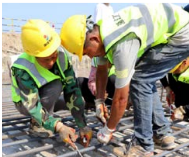
项目钢筋工技能比武大赛
