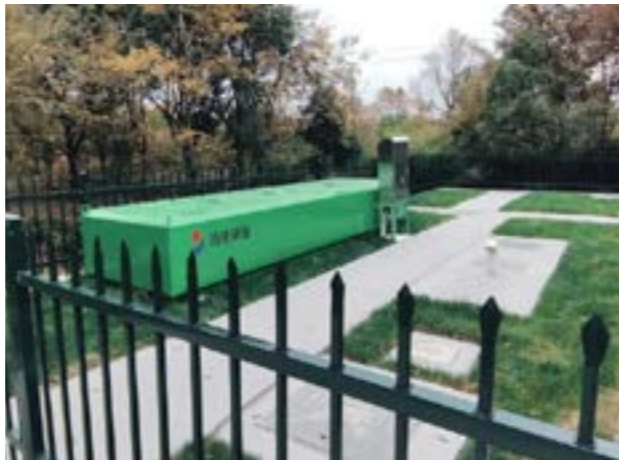
新型生物转盘一体化设备应用现场
