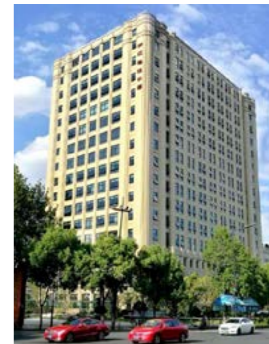
浙江省建投大厦（2018 年国优工程）
