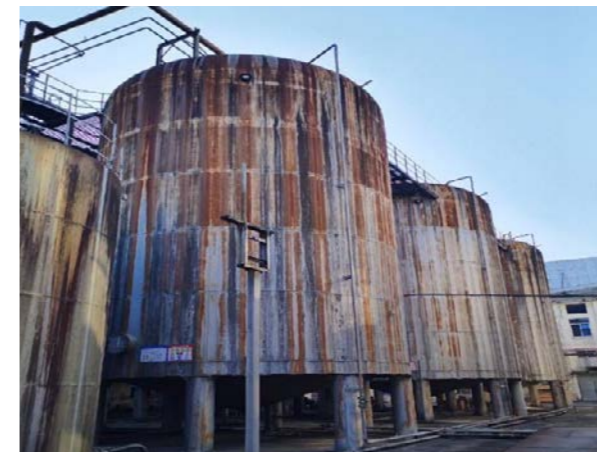
将勾调车间产生的浓缩水处理后回用消防喷淋
