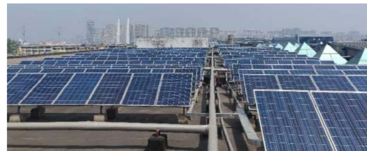
屋顶铺设光伏
