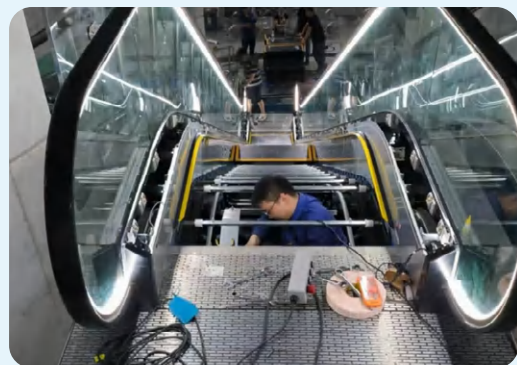
電梯更新改造現場
