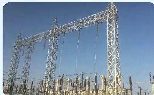
吉布提輸配電工程
