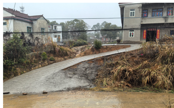
为对点帮扶的枞阳县村民修缮家门口道路
