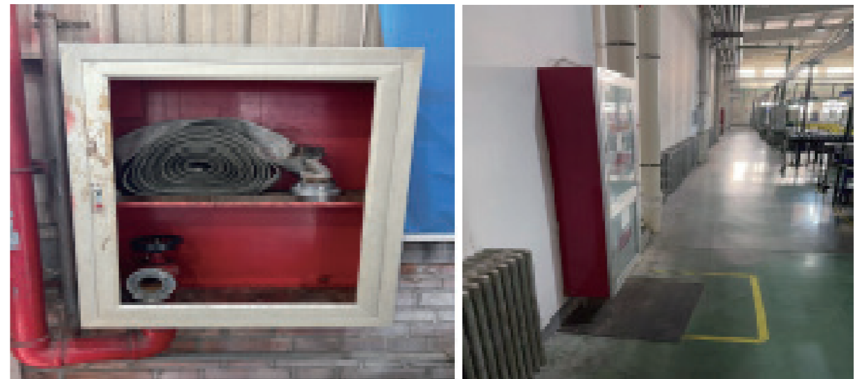
■ 公司安环科开展安全隐患排查，制定整改措施
