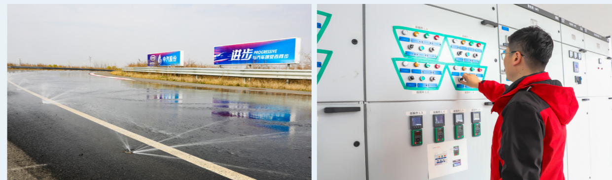
湿操控循环水泵房
