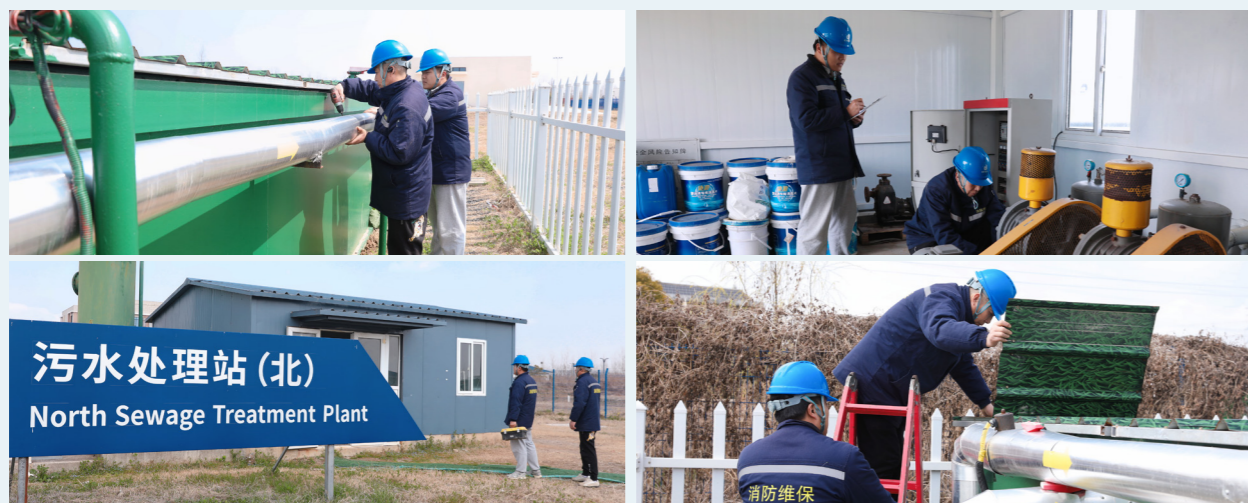
污水处理站管理与设备保养
