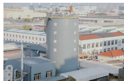
亞東常州污水站厭氧塔
