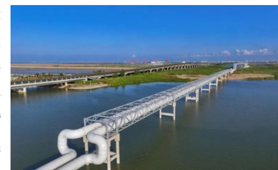
“和气一号”核能供汽项目
