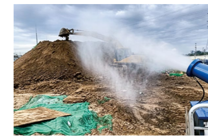
任丘第二热施工现场扬尘源头管控
