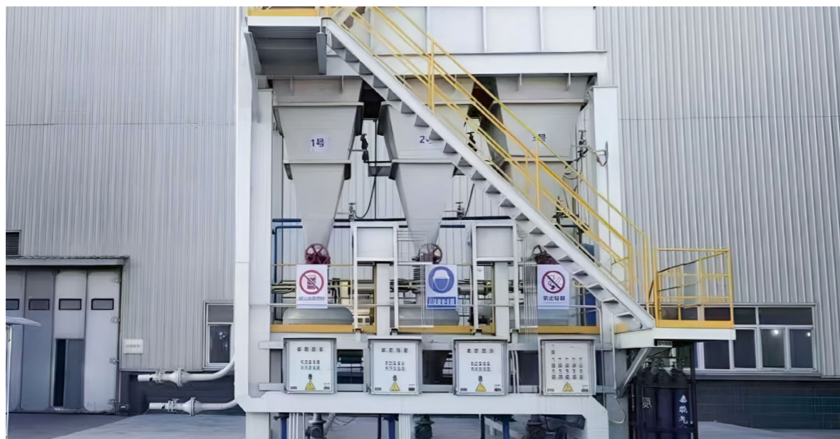
CFB350MW机组复合燃烧快速调峰示范工程
