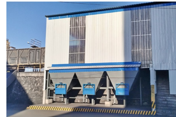
宣化热电翻车机房三面封闭
