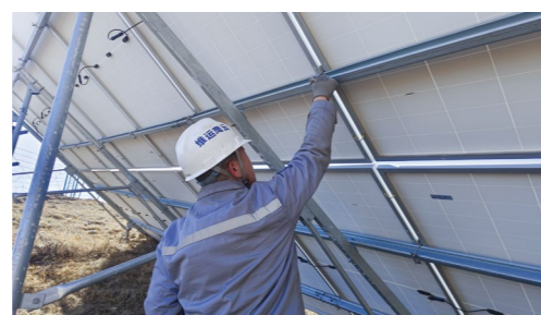
建投国融光伏组件紧固作业
