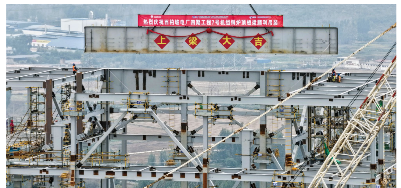
西柏坡电力四期工程7号锅炉首根大板梁顺利完成吊装
