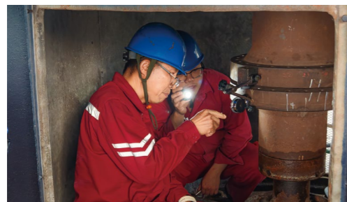
国泰发电开展供热检修
