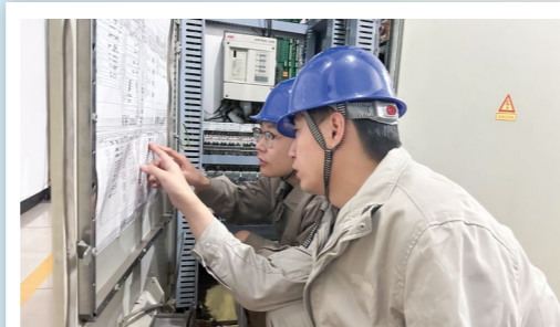
宣化热电#1机组C级检修
