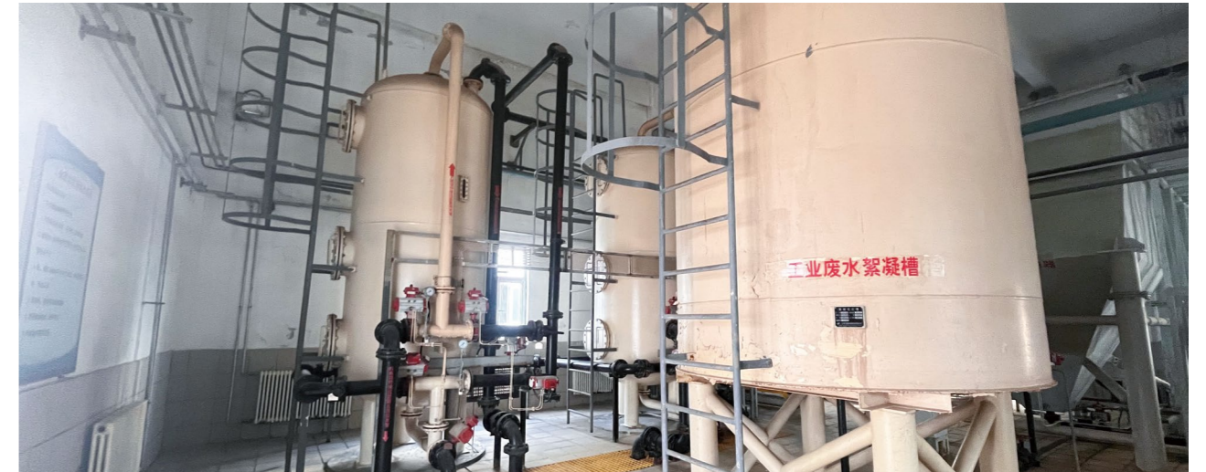
邢台热电厂城市中水替代新鲜水
