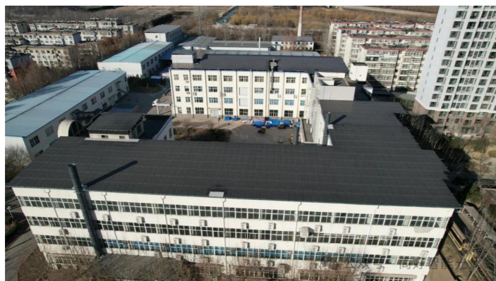
3514公司“屋顶分布式光伏项目”成效显著，每年可生产约200余万度光伏绿电，节省电费超25万元。
