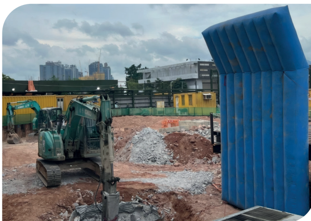
建築工地充氣式隔音屏障
