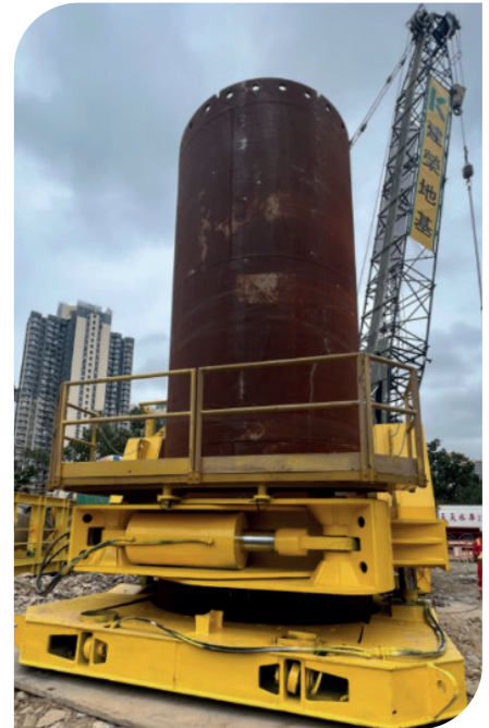
於地盤運作中的改良版磨樁機
