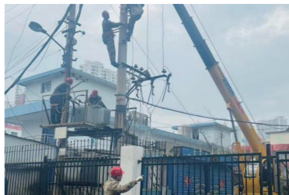
更换节能型变压器
