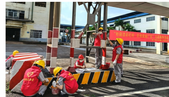
粉刷漆彩栏杆，共创美丽厂区
