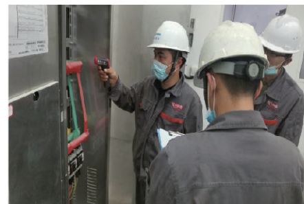
电气安全检查
