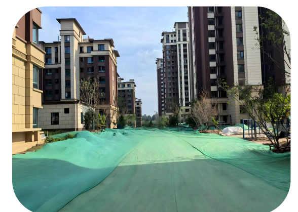
场区严格覆盖
