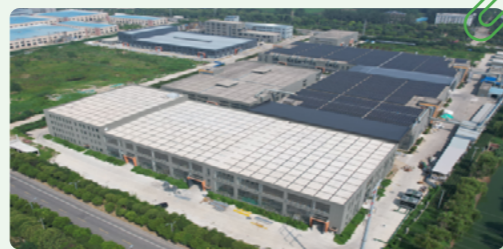
江苏新材料屋顶分布式光伏项目
