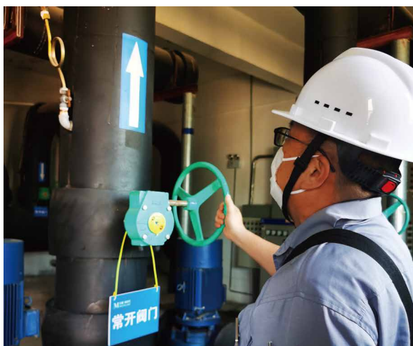
日常供水設施巡檢
