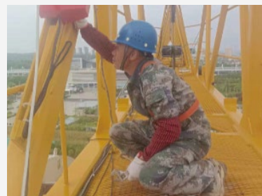
大型機械（塔吊）維護保養檢查
