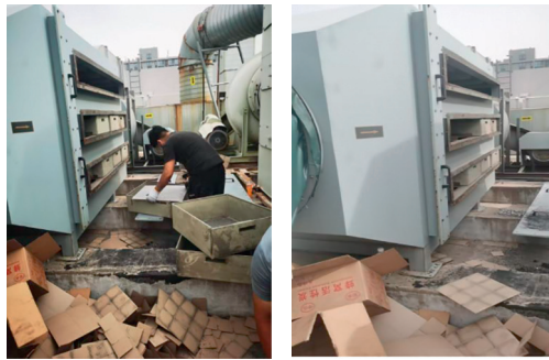
廢氣排出口檢測及廢氣處理設備更新維護
