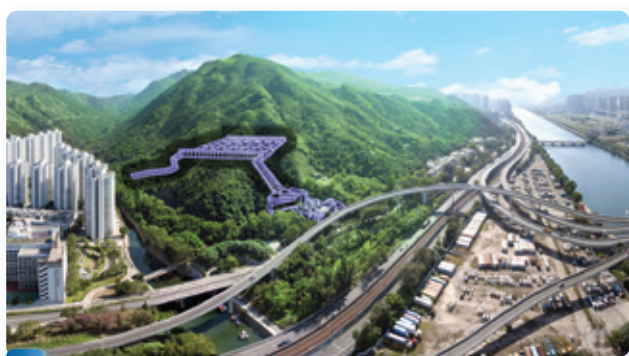
3 搬遷沙田污水處理廠往岩洞－主體岩洞建造工程
