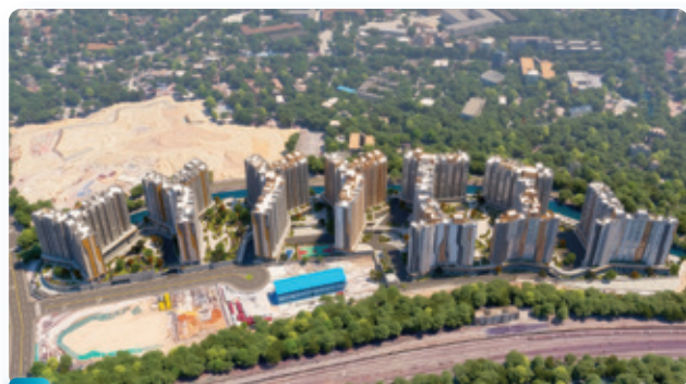
8 新界元朗錦上路第1號地盤第1期及第2期公營房屋發展計劃
