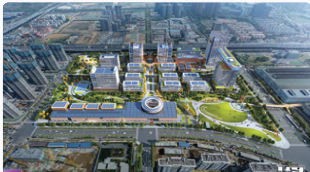
36 安徽合肥瑤海區新能源(氫能)產業園房建項目
