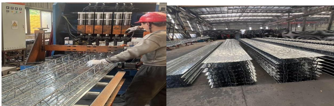
镀锌板桁架筋焊接
