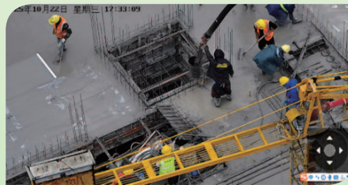
天網檢查樓板澆築
