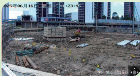
天網檢查現場樁基施工和基坑安全
