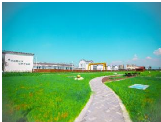
安徽望江污水处理厂项目扩建工程（5万吨/天）
