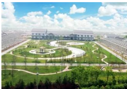
连云港市赣榆新城污水处理厂（总规模 13 万吨/天）
