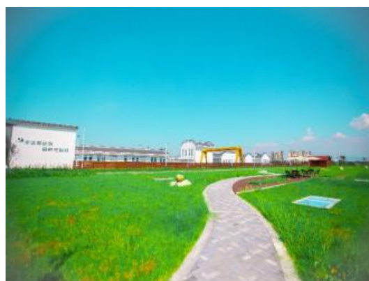
安徽望江污水处理厂项目扩建工程（5 万吨/天）
