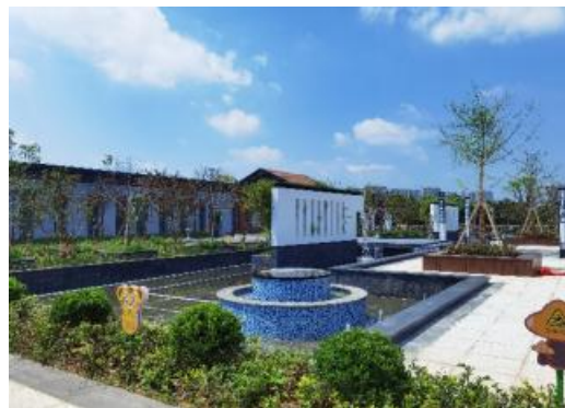
南昌市新建城地下生态水厂（2 万吨/天）
